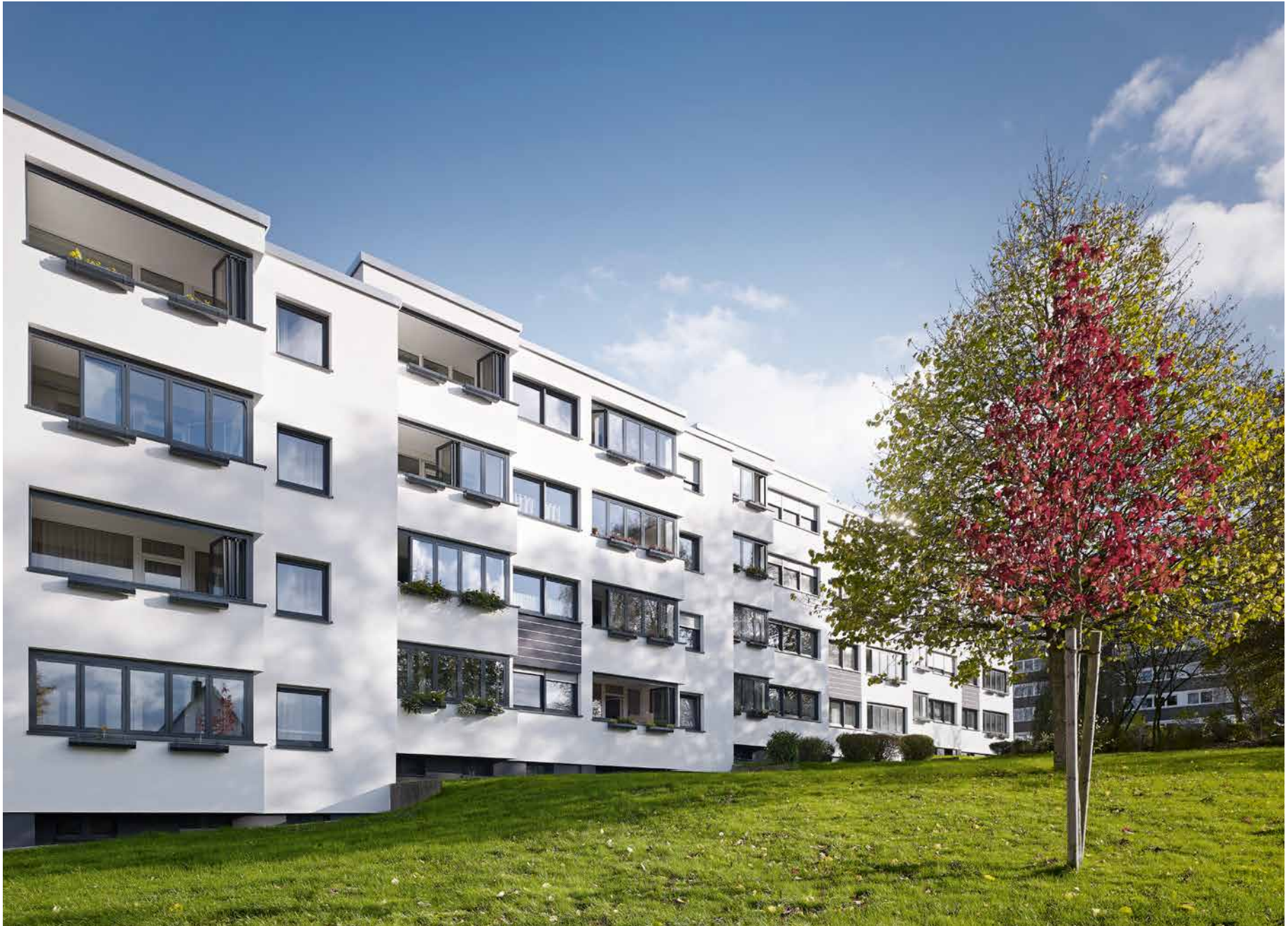
Balkone verglasen, Räume schaffen · Hattingen, Deutschland
